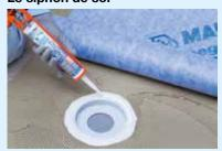
Coller la membrane **MAPEGUARD WP 200** sur la collerette du siphon à l'aide du mastic **MAPEFLEX MS 45** ou **MAPESIL AC** à environ 1 cm du bord du siphon (coté écoulement). Après séchage du mortier colle, découper la membrane.
