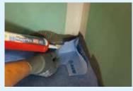
Le collage des pièces d'angles s'effectue à l'aide du mastic **MAPEFLEX MS 45** ou **MAPESIL AC** pour la réalisation d'une étanchéité.
