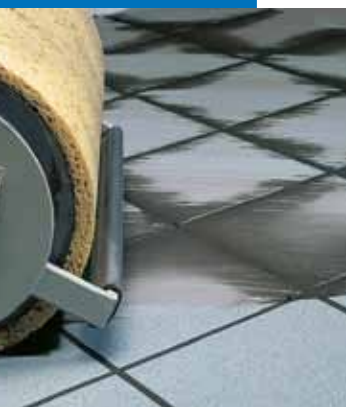
Finition des joints en sol à la machine
