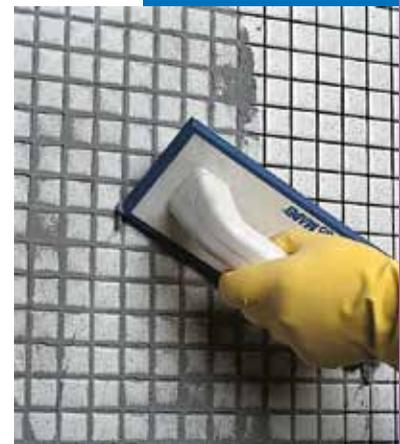
Remplissage des joints entre carreaux de pâte de verre à la spatule, dans une salle de bains
