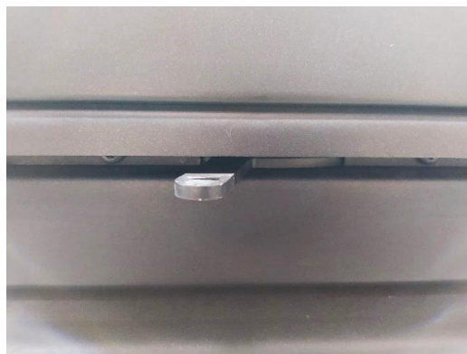
Figure n°7 - Position du registre d'arrivée d'air secondaire pour la puissance thermique nominale
